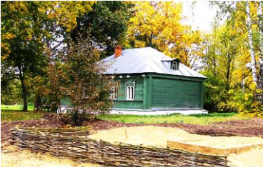
Деревянный дом (флигель)
